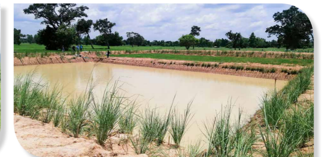
สระพวงกักเก็บน้ำ ชุมชนแม่ขมิ้น พื้นที่ จ.แพร่
