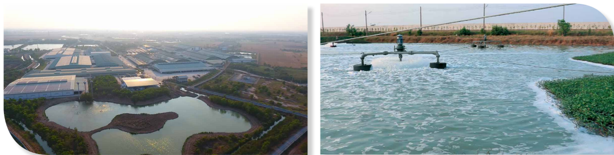
พื้นที่ระบบบำบัดน้ำเสียโรงงาน จ.ปราจีนบุรี
